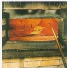
Nach dem Aufschneiden wird die Glaswalze erneut erhitzt, aufgeklappt und zu einer Tafel glattgebügelt.
